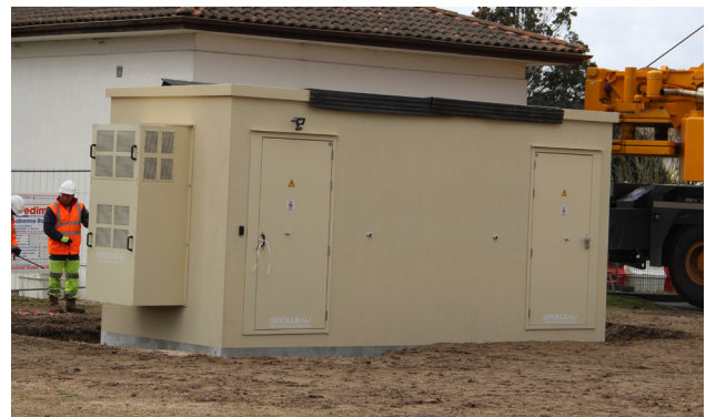
Pose d'un shelter (ou local technique de télécommunications)
